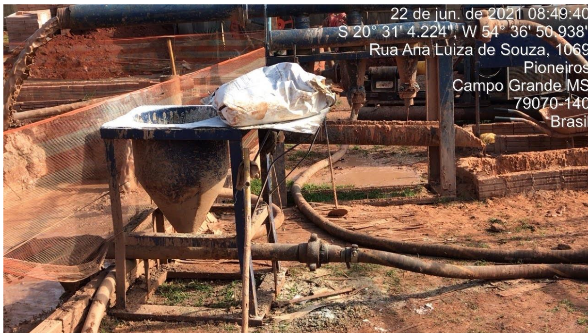
Figura 10 - Misturador de aditivo de fluido de perfuração
