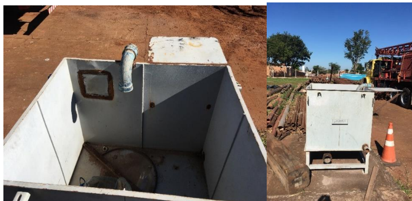
Figura 8 - Tanque de preparado de calda de cimentação
