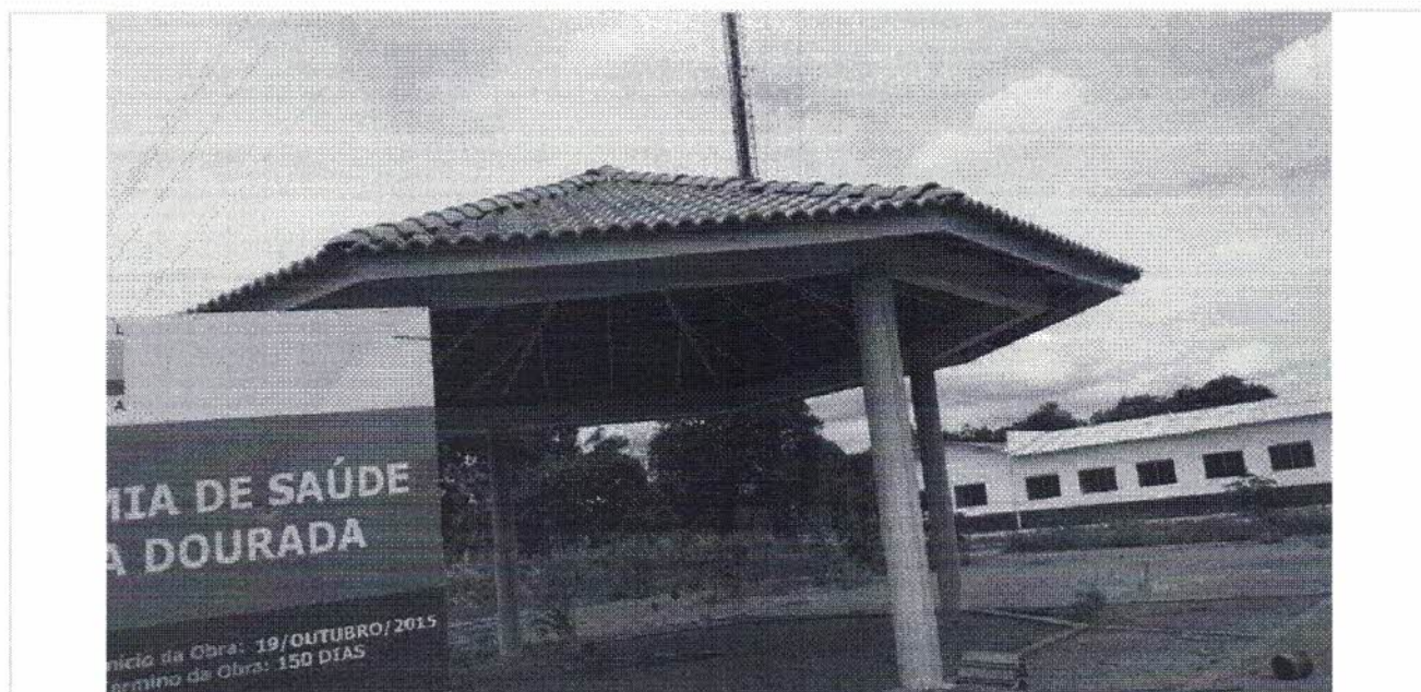
Fotografia da 3ª etapa de execução Data da última atualização: 04/11/2016
