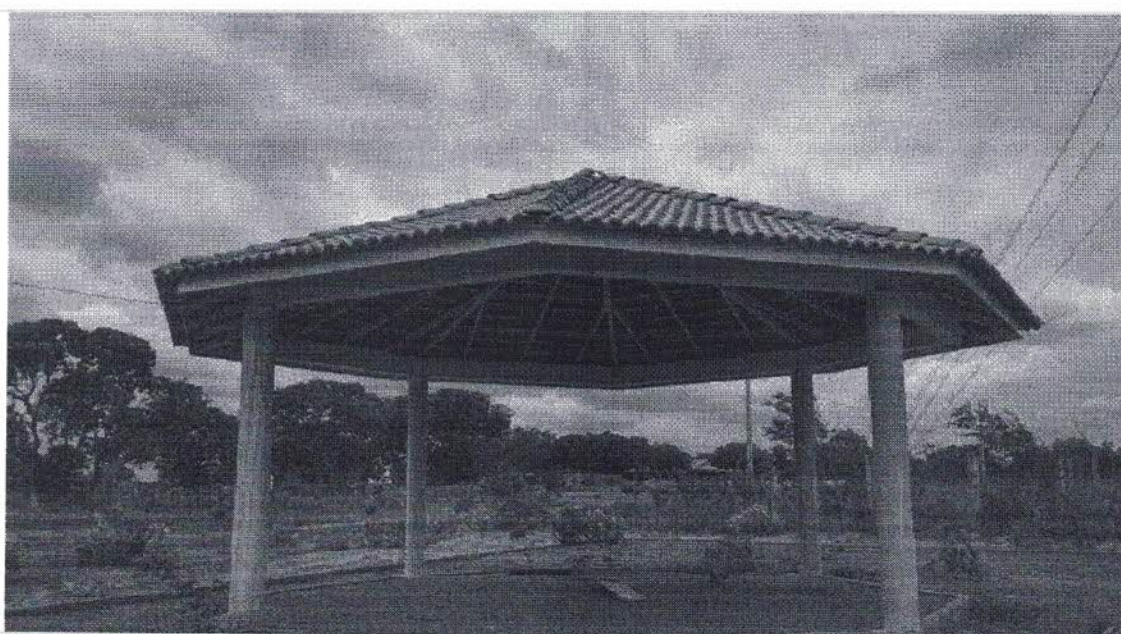
Fotografia da 3ª etapa de execução Data da última atualização: 04/11/2016
