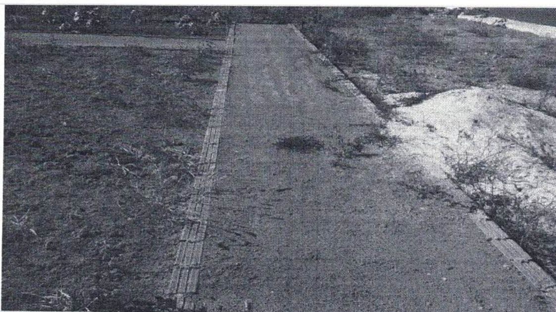
Fotografia da 2ª etapa de execução Data da última atualização: 26/07/2016
