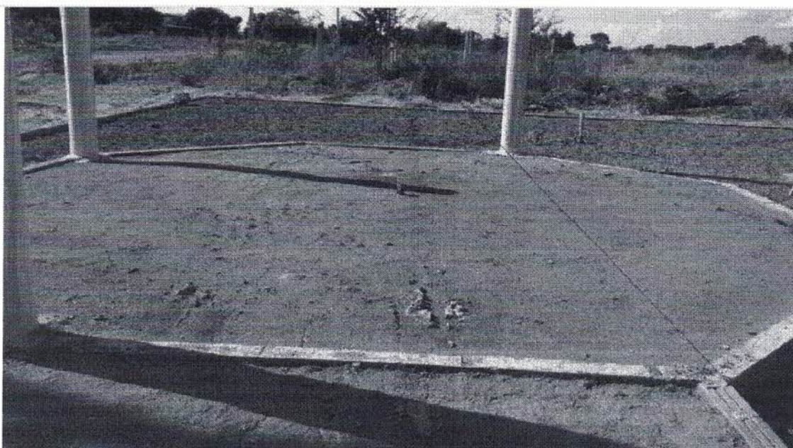
Fotografia da 2ª etapa de execução Data da última atualização: 26/07/2016
